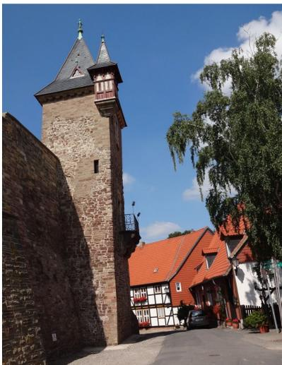
Die Bauarbeiten am Wasmusturm liegen auf der Zielgeraden. Beleg dafür ist auch dieses Foto vom 17.07.2013. Zurzeit werden im Außenbereich Restarbeiten erledigt. Hervorzuheben sind hier das Anbringen der schmiedeeisernen Geländer und Gitter für die Türmerstube. Danach steht die Restaurierung der Türmerstube auf dem Plan. So können wir davon ausgehen, dass die Arbeiten am Wasmusturm noch im Sommer beendet werden können.
