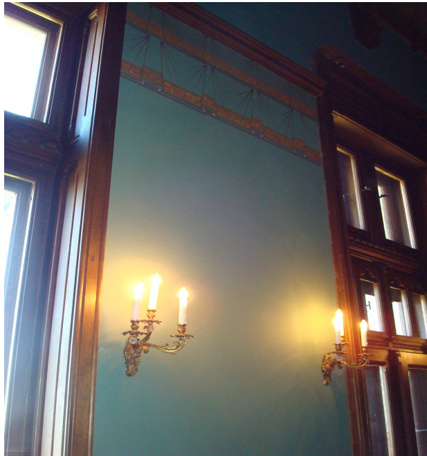
Fertiggestellter Bauabschnitt an der Fensterseite des Festsaaes (Foto vom 21.04.2009)
